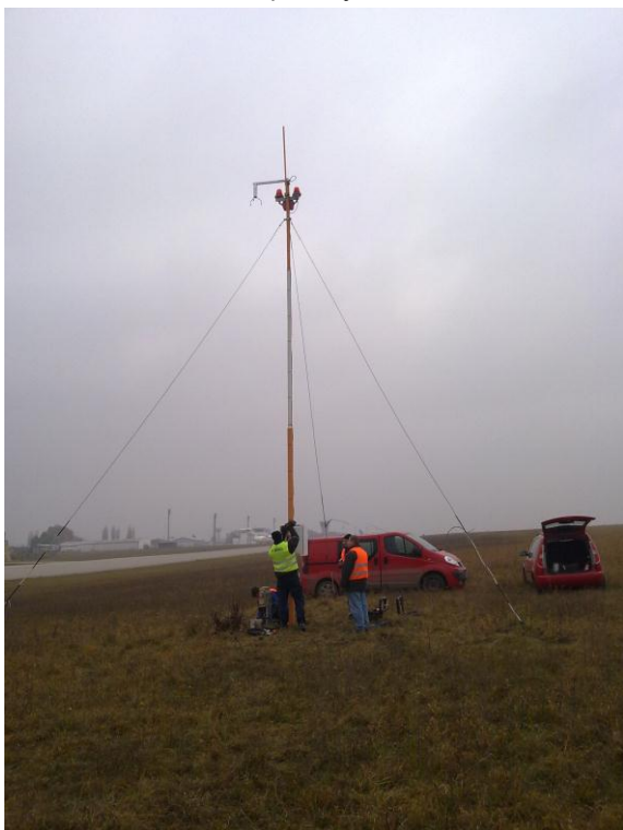
Ultrasonické anemometry WMT702, které nahradily klasické anemometry WAAWAV151 v pozicích TDZ RWY11 a TDZ RWY29 na letišti Karlovy Vary
