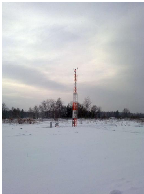
Přemístěný 10 m příhradový stožár na TDZ RWY29 na letišti K. Vary
