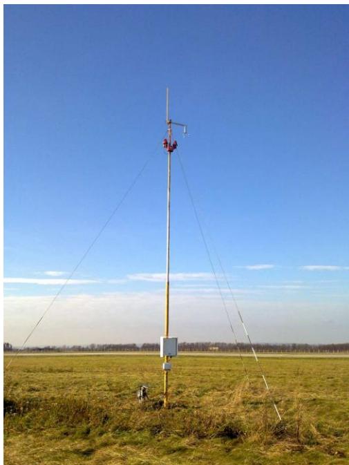
Ultrasonický anemometr WMT702 na TDZ RWY22 na letišti Ostrava/Mošnov
