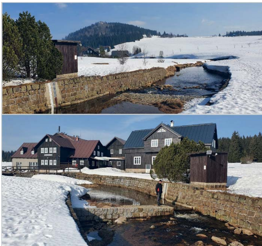
Obr. 4 Současný stav vodoměrné stanice, po rekonstrukci prahu v roce 2015 jsou běžné průtoky převáděny přes měrný přeliv u levobřežní zdi v blízkosti vodočtu a tlakových čidel. I při minimálních vodních stavech je tak dosaženo kvalitního vyhodnocení průtoku.
