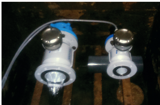
Obr. V.8 Průtokoměry na pramenech PP0279 Častov a PP0620 Častov.
