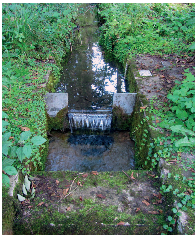
Obr. V.5 Pramen PP0237 Košátky s Ponceletovým přelivem o šířce 40 cm (vlevo), pramen PP0230 Kovář s obdélníkovými výřezy o šířce 10 cm (vpravo).
