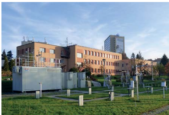
Budova ČHMÚ v Ostravě, kde sídlí RPP, které hraje zásadní roli při sledování hydrometeorologických jevů v Moravskoslezském kraji. Foto: Archiv ČHMÚ.
