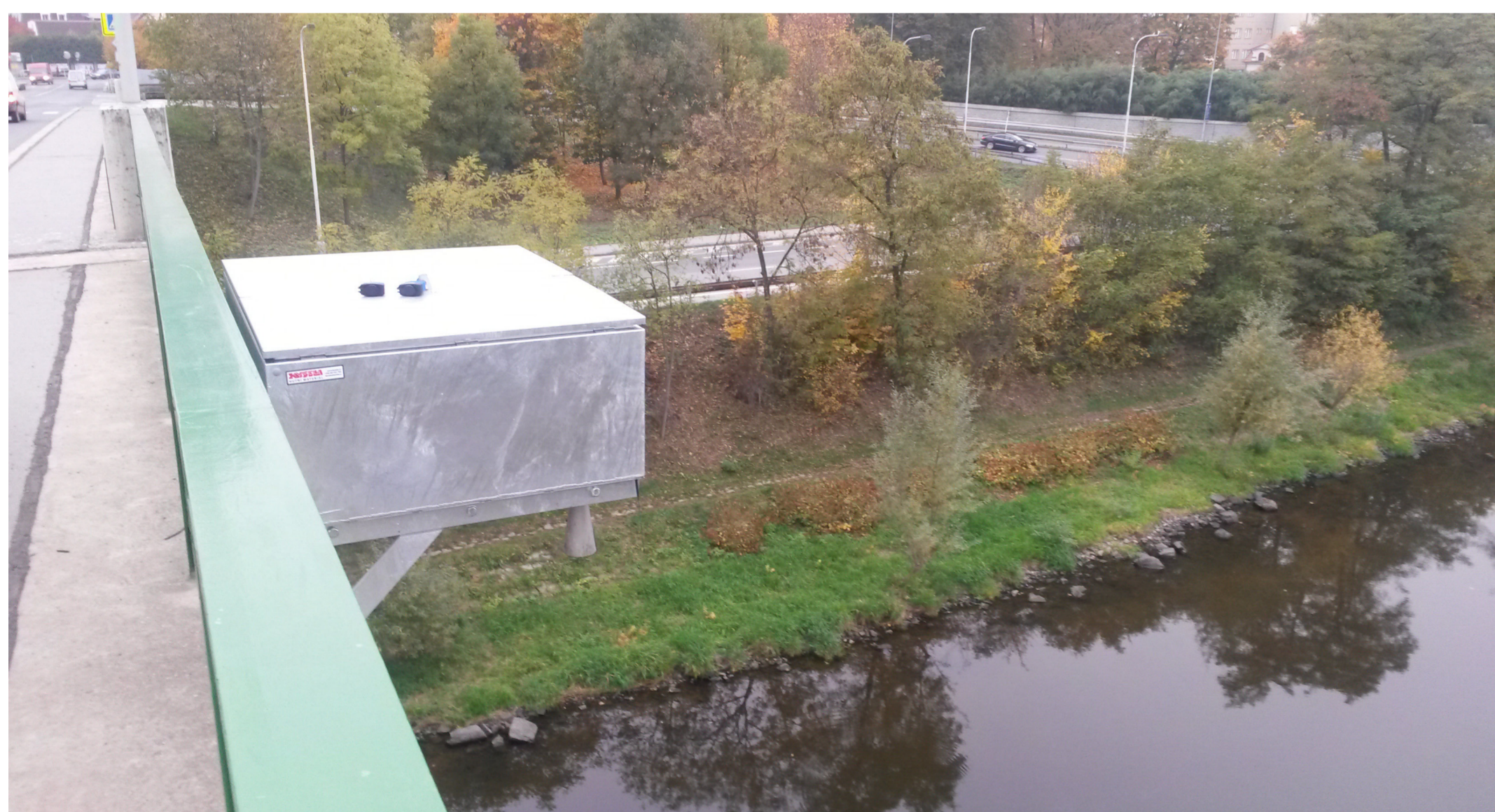
Radarové čidlo – Zbraslav.
