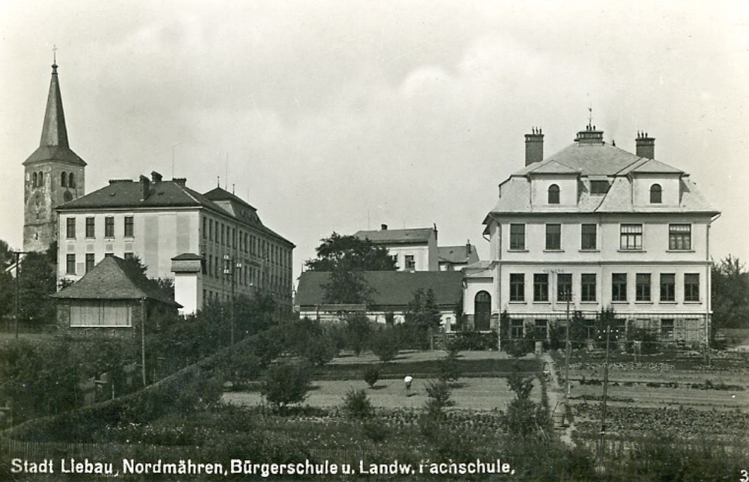
Budova zemědělské lidové školy ve Městě Libavá
