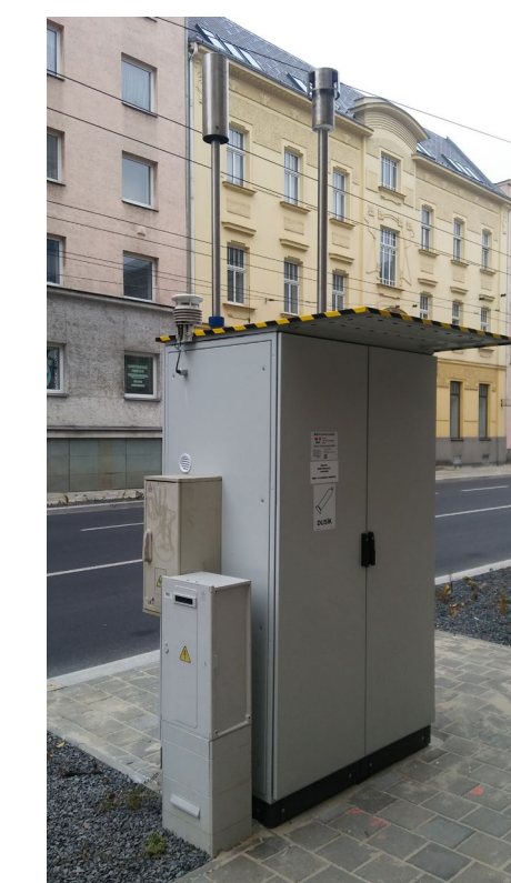
Dopravní hot- spot stanice Ostrava- Českoobrátská
